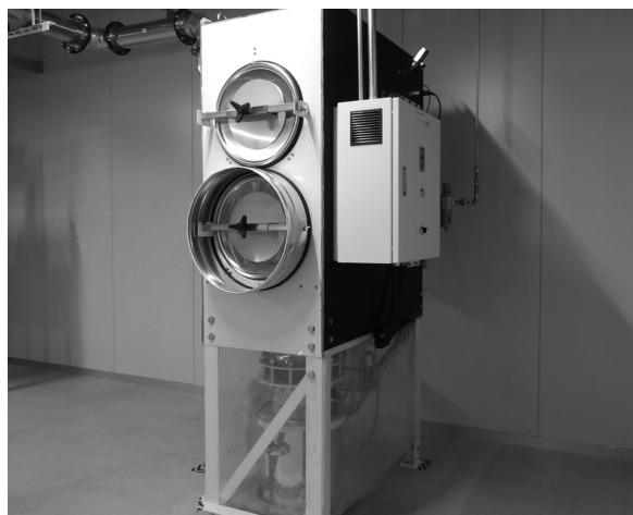
写真4 バグイン・バグアウト方式PLC型集塵機
